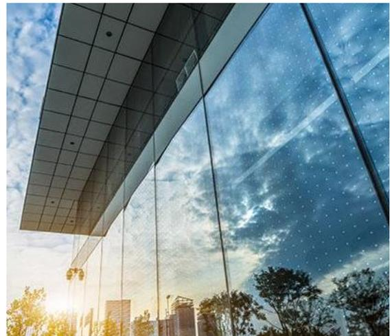
**Abb. 28:** Glasfassade mit Punktmuster, Quelle: SEEN AG
