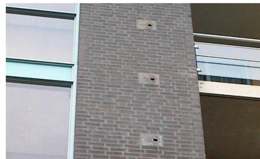
Abb. 19: Nist- und Einbaustein Typ 25, Einbaubeispiel Fassade (Quelle: [www.schwegler-natur.de](http://www.schwegler-natur.de))
